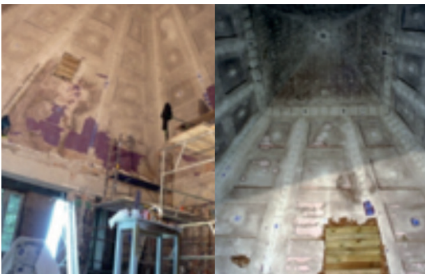
Konservierungs- und Sanierungsarbeiten (© Borussia)
